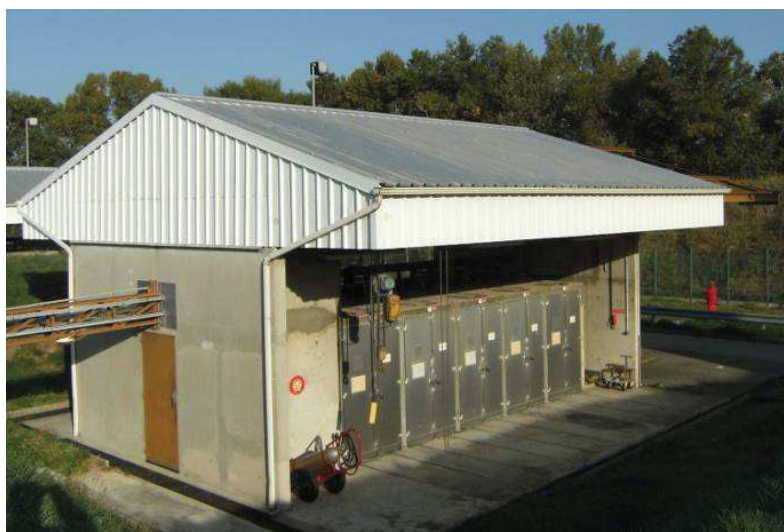
Figure 9 : Photographie d'un des trois bâtiments de stockage du parc CIF 3
