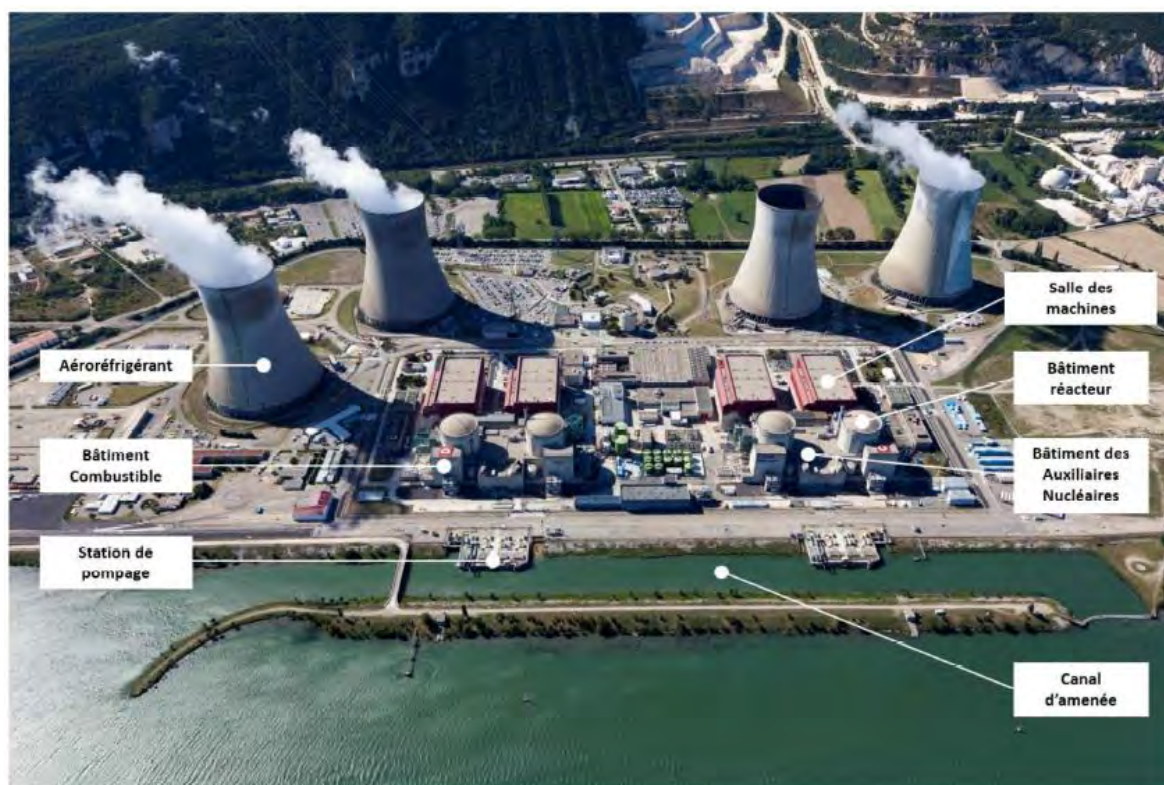
Figure 41 : Vue aérienne et implantation des principales installations du CNPE de Cruas-Meysse
