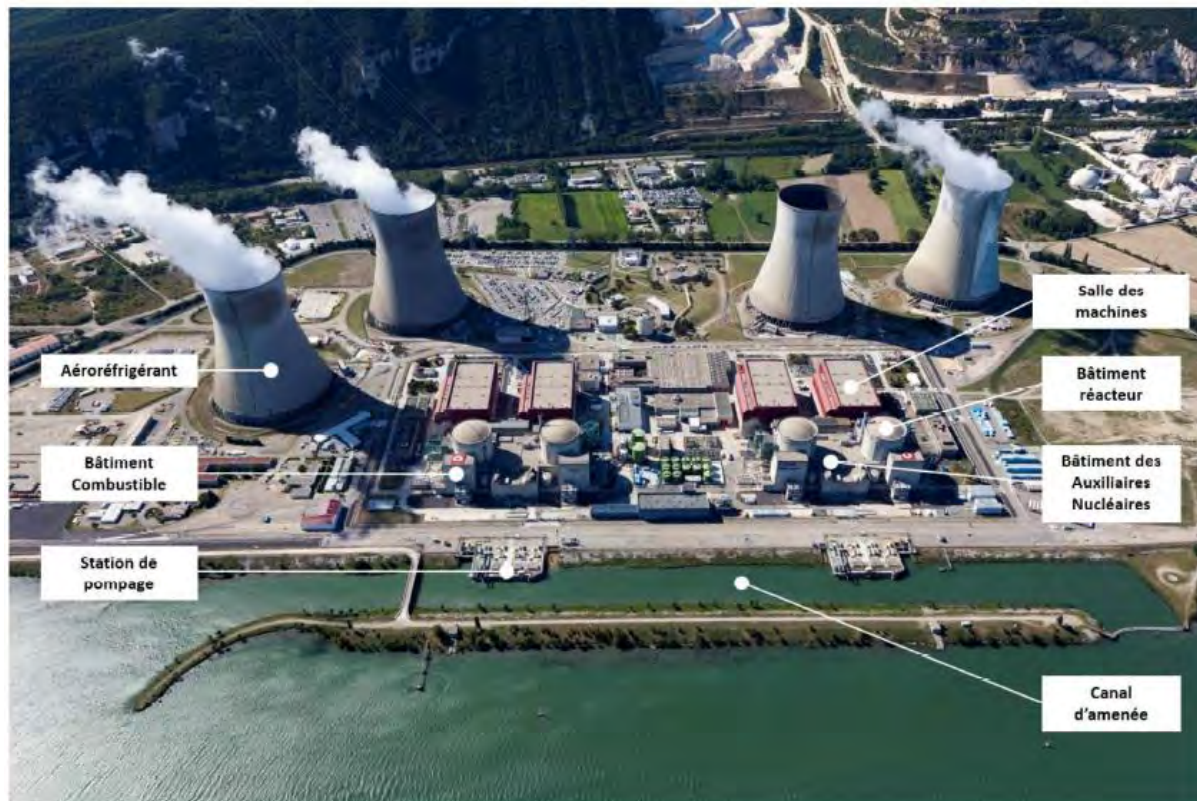
Figure 3 : Implantation des principaux ouvrages du CNPE de Cruas-Meysses
